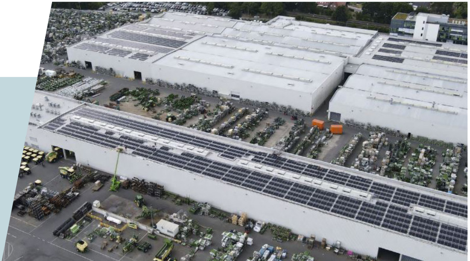
Photovoltaikanlage am Standort in Spelle
